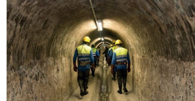
Red de alcantarillado de Barcelona. España.
