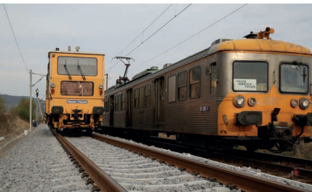
Tramo ferrocarril Atel-Micasasa y Sighisoara-Atel.
