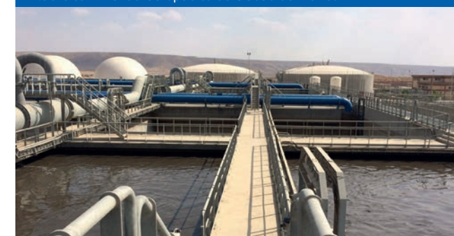
Depuradora New Cairo. Egipto.
